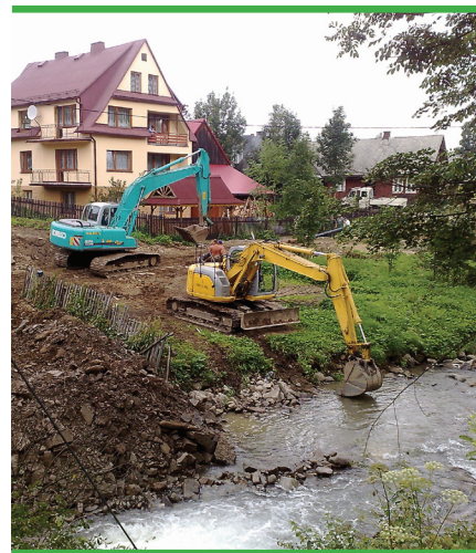
Budowa sieci kanalizacyjnej w Gminie Jeleśnia
