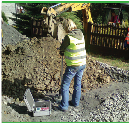
Budowa sieci kanalizacyjnej w Gminie Łodygowice
