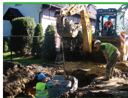
Budowa sieci kanalizacyjnej w Gminie Węgierska Góra
