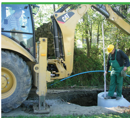
Budowa sieci kanalizacyjnej w Gminie Koszarawa
