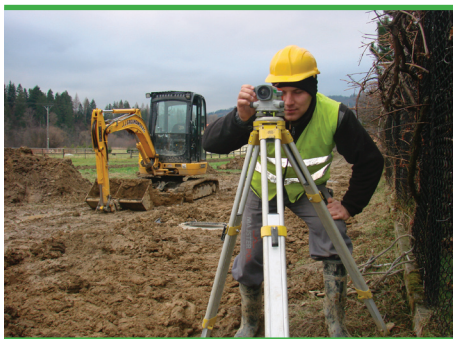
BUDOWA SIECI KANALIZACYJNEJ W GMINIE RAJCZA
