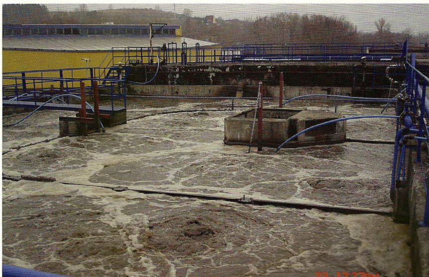
Oczyszczalnia ścieków w Cięcinie będzie po modernizacji miała przepustowość 5,3 tysięcy metrów sześciennych ścieków na dobę.
