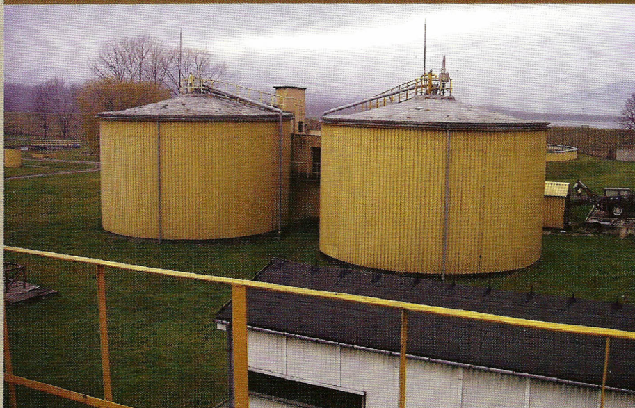
Modernizacja obiektu w Żywcu pozwoli na oczyszczanie 42 tysięcy metrów sześciennych na dobę.
