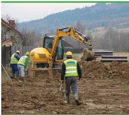
BUDOWA KANALIZACJI W GMINIE RAJCZA
