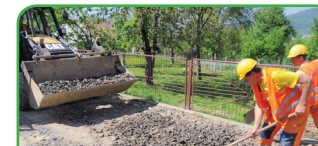
MIASTO ŻYWIĘC Kontrakt 24 – Kontrakt zakończony Zakres prac: 58 km sieci kanalizacyjnej oraz 30 km sieci wodociągowej Wartość Kontraktu: 68 929 674 zł brutto.
