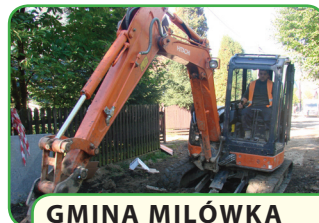
GMINA MILÓWKA Kontrakt 12a – Kontrakt zakończony Zakres prac: ponad 5 km sieci kanalizacyjnej Wartość Kontraktu: 2 128 690 zł brutto
