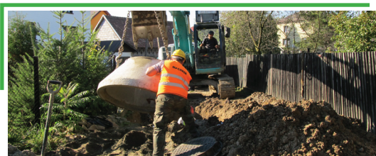
Budowa sieci kanalizacyjnej i wodociągowej na terenie objętym inwestycją
