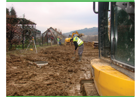
DO UKOŃCZENIA BUDOWY SIECI KANALIZACJI SANITARNEJ I WODOCIĄGOWEJ NA ŻYWIECCZYŹNIE, POZOSTAŁY NIESPEŁNA TRZY LATA.
