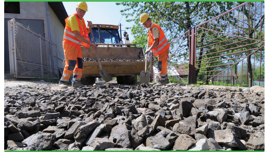
KOPANIE SIECI KANALIZACYJNEJ
