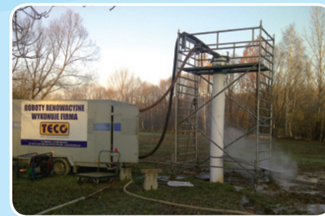
Proces instalacji rękawa - uszczelnianie sieci
