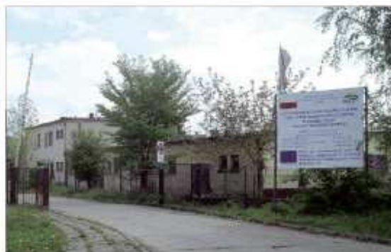
Montaż tablicy informacyjnej przed bramą wjazdową
