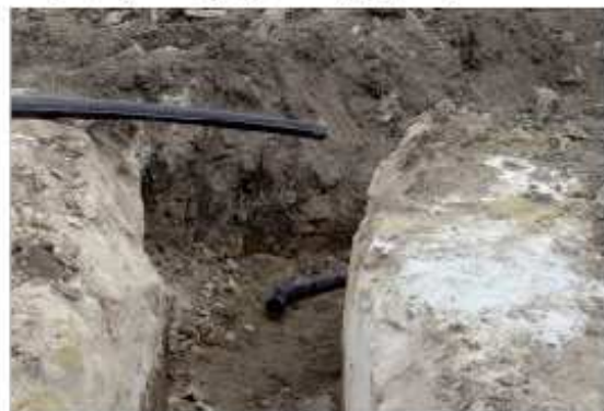
Budowę rurociągu wody.
