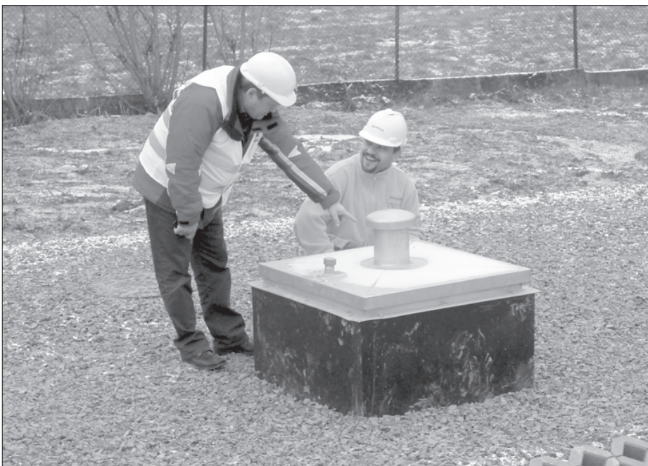
Realizacja kontraktu nr 24 „Przepompownia P5”.
