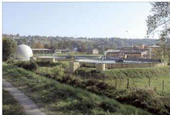
Istniejąca oczyszczalnia w Żywcu zostanie całkowicie przebudowana.
