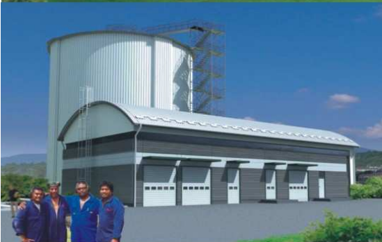
Modernizacja i rozbudowa Oczyszczalni Ścieków w Żywcu, ul. Bracka
