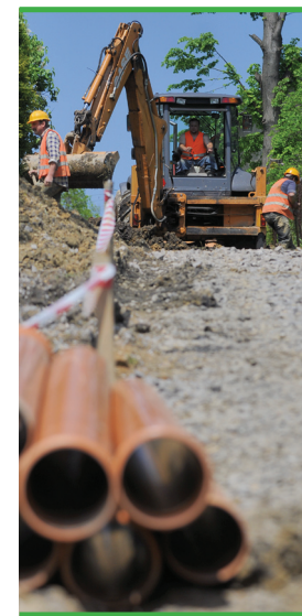
BUDOWA SIECI KANALIZACYJNEJ I WODOCIĄGOWEJ W GMINIE ŻYWIEC
