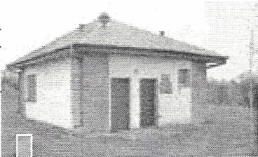
Stacja wodociągowa Pawłów
