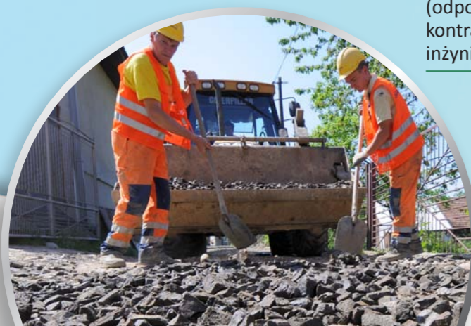
Prace wykończeniowe na terenie Żywca-Moszczanicy
